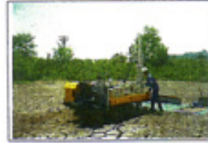
貫入状況 (後方より)
