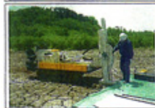
貫入状況 (前方より)
